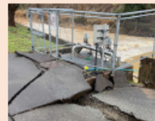
水道の復旧 (被災した浄水場)
